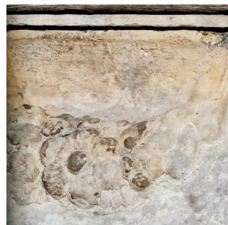
Detail podstavce s nánosem minerálních krust
