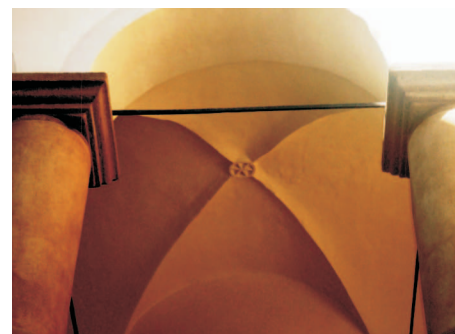
Detail hřebínkové klenby v arkádovém ochozu
